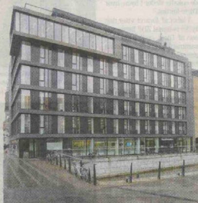
Åboulevarden 11. 1960'ers-byggeriet har fået et helt nyt og moderne udtryk. Bygherre: Åboulevarden Aps. Arkitekt: Arkitema Architects.
