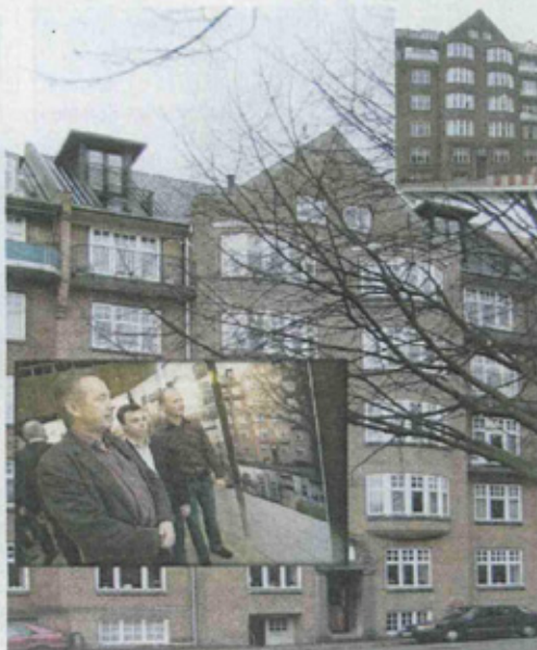
FORANDRING. Det store foto er den nyistandsatte Marselisborg Allé 30 B med nye karnapper. Det lille foto er ejendommen før renoveringen. Fra venstre er det arkitekt Torben Skov, Colliers, Adam Kraft og vicevært Jonas Kraft. Foto: Kim Haugaard
